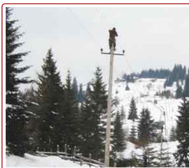
Przebudowa sieci elektrycznych 0,4-10 kV, miejscowość Jablunycza, rejonu jaremczańskiego
