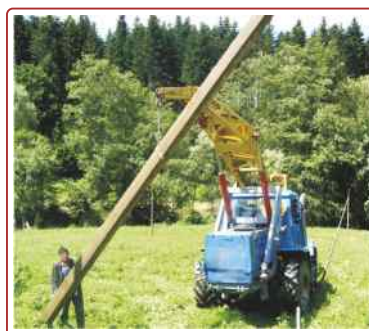
Przebudowa sieci elektrycznych 0,4-10 kV, miejscowość Utoropy, rejonu kosiwskiego
