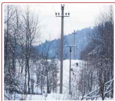
Budowa linii przesyłowych 10 kV, miejscowość Usteriky Biloberizka, rejonu werchowyńskiego
