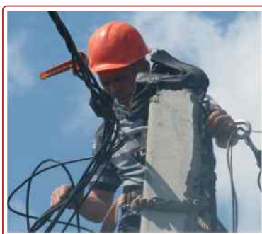
Przebudowa podstacji 35 / 10 kV, miejscowość Miżhiria, rejonu bohorodczańskiego
