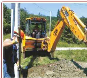
Przebudowa sieci elektrycznych 0,4-10 kV, miejscowość Słoboda, rejonu kołomyjskiego
