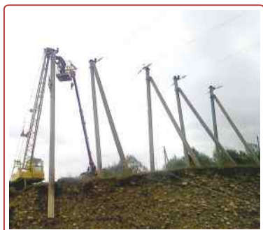
Budowa linii przesyłowych 10 kV, miejscowość Delatyn, rejonu nadwirniańskiego
