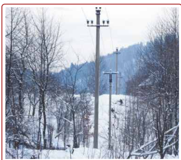
Будівництво ЛЕП 10 кВ Устеріки-Білоберізка, Верховинського району.
