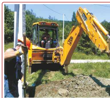
Реконструкція електромереж 0,4-10 кВ, с. Слобода Коломийського району.
