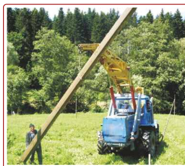
Реконструкція електромереж 0,4-10 кВ, с. Уторопи Косівського району.
