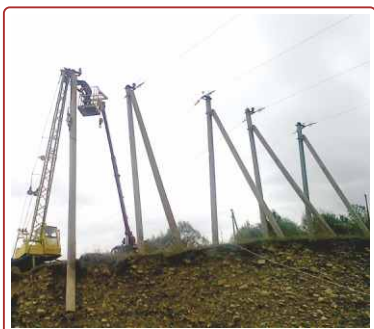
Будівництво ПЛ 10 кВ, смт Делятин Надвірнянського району.
