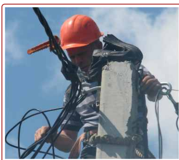
Реконструкція підстанції 35/10 кВ, с. Міжгір'я Богородчанського району.
